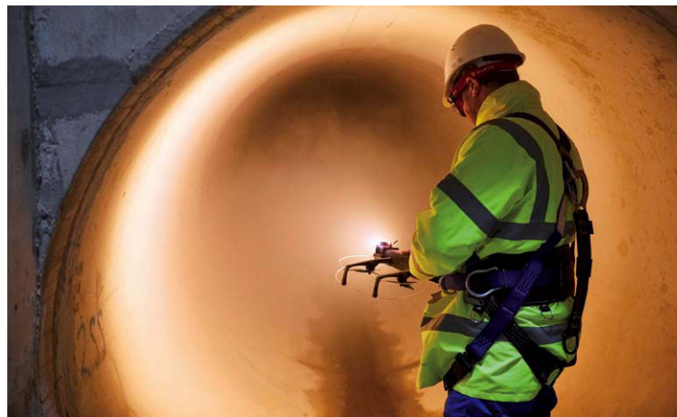
Die Indoor-Drohne bei der Kanalinspektion (Bild: simon eymann | kopterwork)
